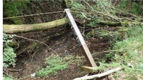
(写7 標準標識の基礎が侵食により倒壊)
