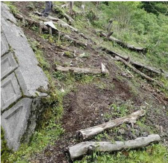
(写31 腐食した丸太階段が流出)
