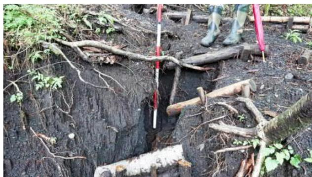
(写32 激しい侵食による丸太階段の損傷)
