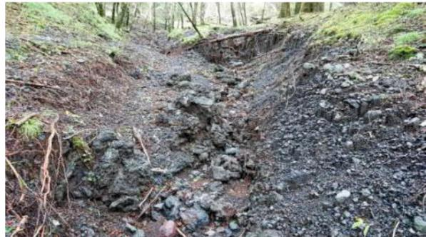
(写 40 歩道へ雨水が流れミズ道化し、段差が拡大)
