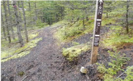
(写4 標識の根元が侵食により露出、倒壊の恐れ)
