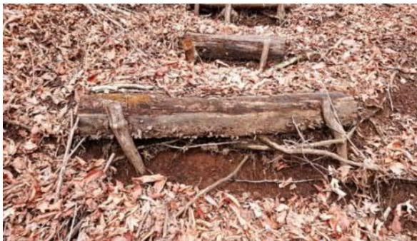
(太い丸太は腐食、丸太材の下は削れている)
