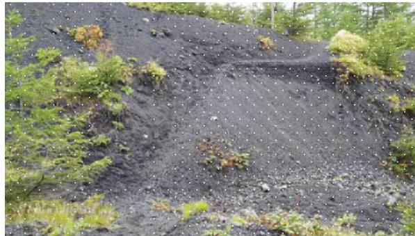
(写 49 路面が崩落し易く対策が必要な箇所)
