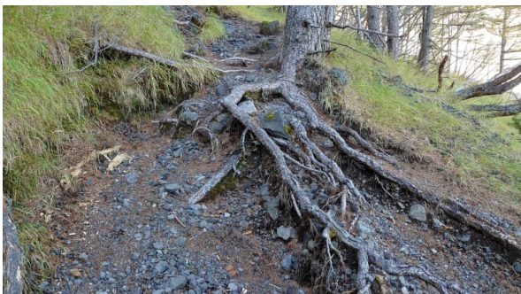
(歩道拡幅、複線化、根の露出・損傷、Hコース)
