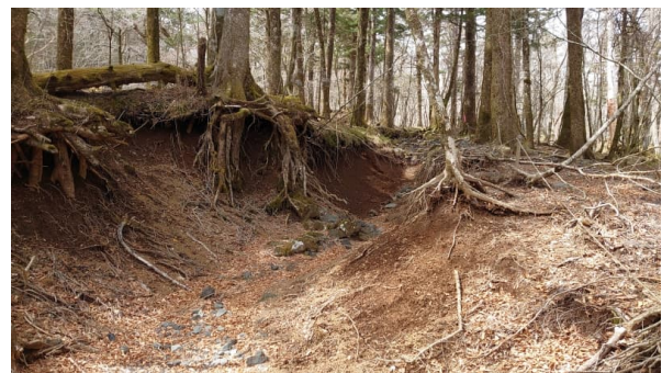
(UTMF 後に侵食で路肩が崩れた歩道)
