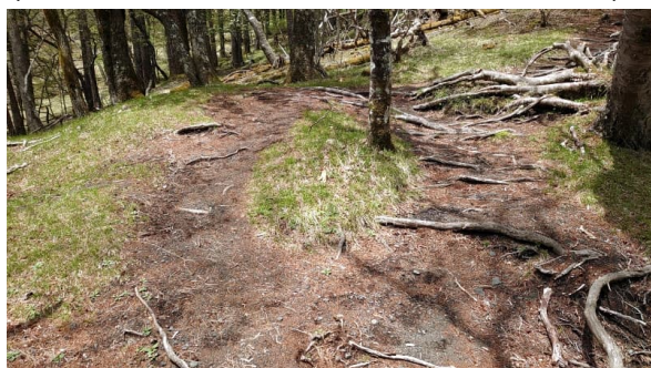
(歩道複線化、樹木根損傷、植生損傷)
