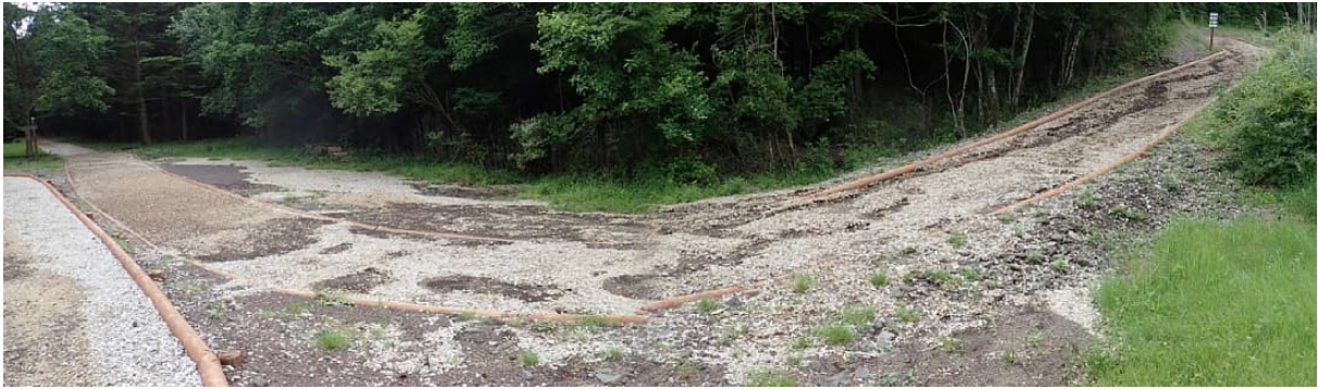
(傾斜箇所ではクロスカントリーコースからウッドチップが外に流れ出て植生を覆う。水ヶ塚公園)
