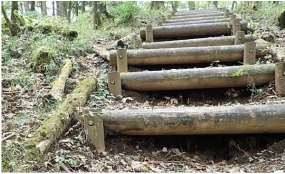
(土砂が流れ段差が大きく通行困難、Lコース)
