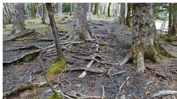
(直線的迂回路、歩道拡幅、樹木根や植生損傷)
