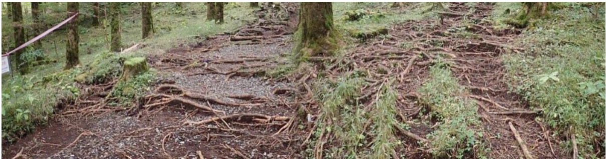
(土砂の流失、木の根の露出の拡大。複線化した新しい道も歩きにくくなっている。Lコース)
