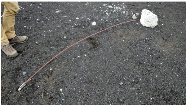
(歩道に露出しているワイヤーケーブル、1コース)
