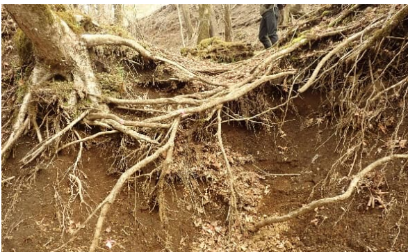
(侵食で樹木根露出、損傷、黒塚南東)
