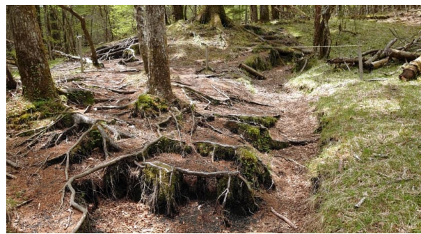
(根の露出損傷、歩道複線化、Iコース)
