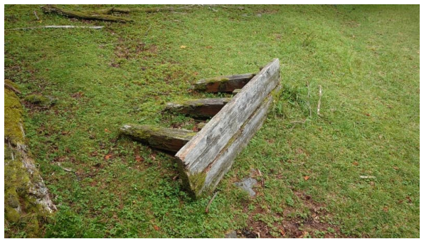
(腐食して倒れたベンチ、Eコース水平歩道)
