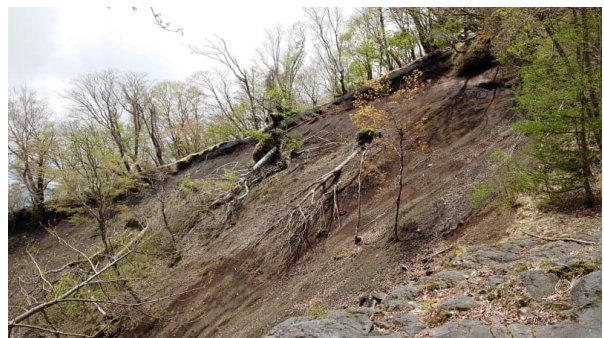
(崩壊が進む砂沢右岸)
