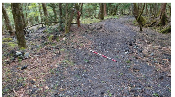
(堆積砂礫の歩道にポール方向に水切り設置要望)
