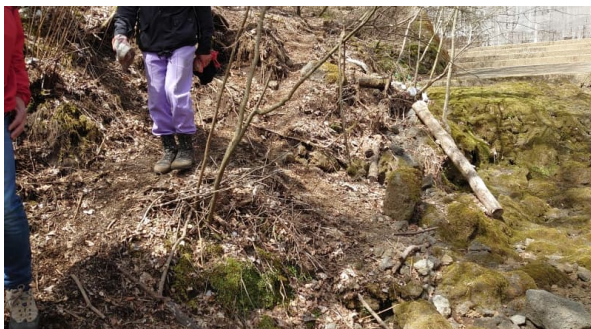
(さらに侵食が進んだ丸太階段跡、大調整池直下)
