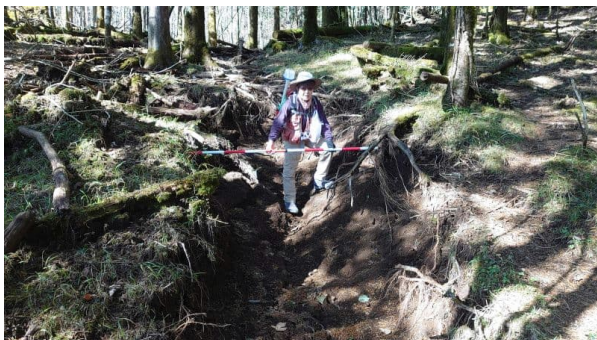
(水ミチ化、根露出・損傷、歩道拡幅、複線化)
