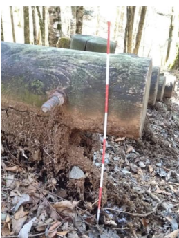
(激しい浸食がみられ、丸太階段が危険な状態。、西臼塚Lコース)
