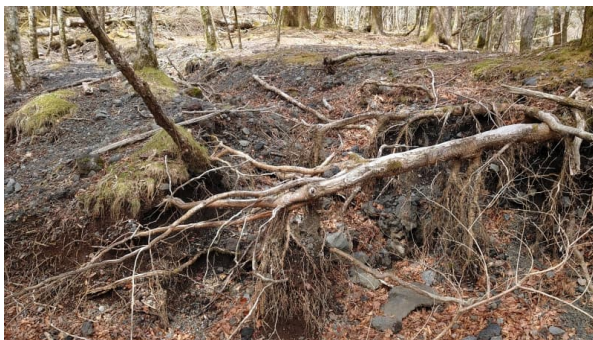
(侵食で大きな根が露出、この地点は補修必要)
